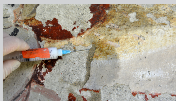
Festigung der Malschicht durch Hinterspritzen
