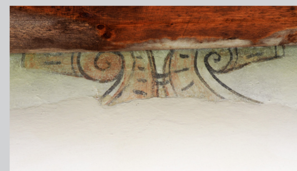
freigelegtes Rollwerk an der Südfassade
