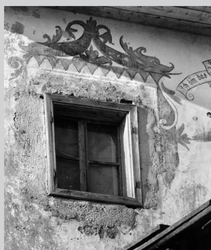
nach Einbau der neuen Fenster, vor 1964?
