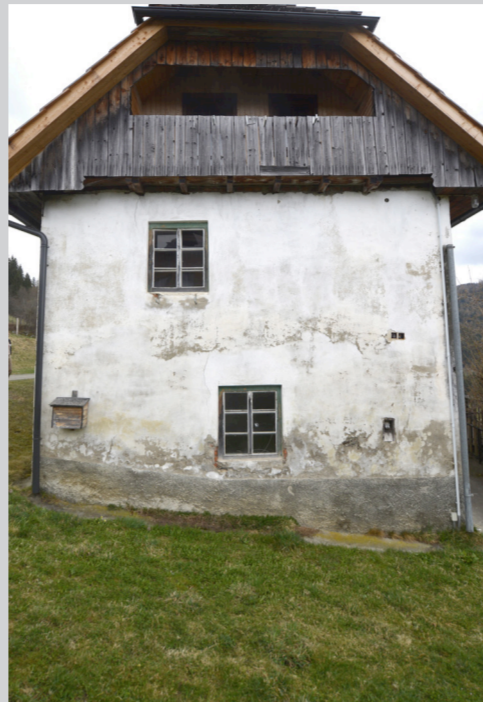
Zustand vor der Restaurierung 2017, Westfassade
