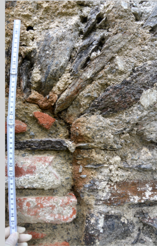
Detail Mauerwerk Nordfassade Fenster, gemauertes Gewölbe für Öffnung mit verrußter Putzoberfläche (Rauchküche)
