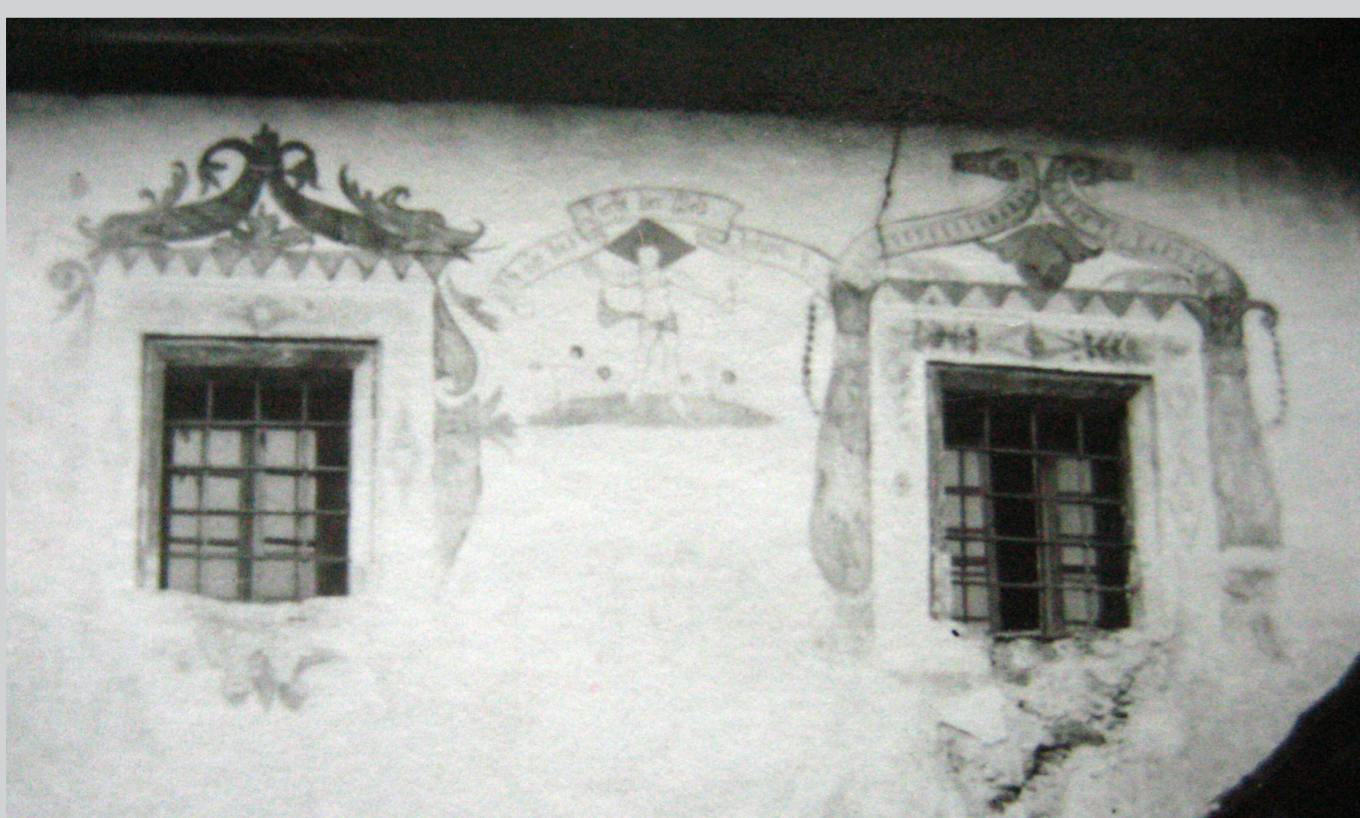
Südfassade 1955 Detail, ursprüngliche Fenstersituation
