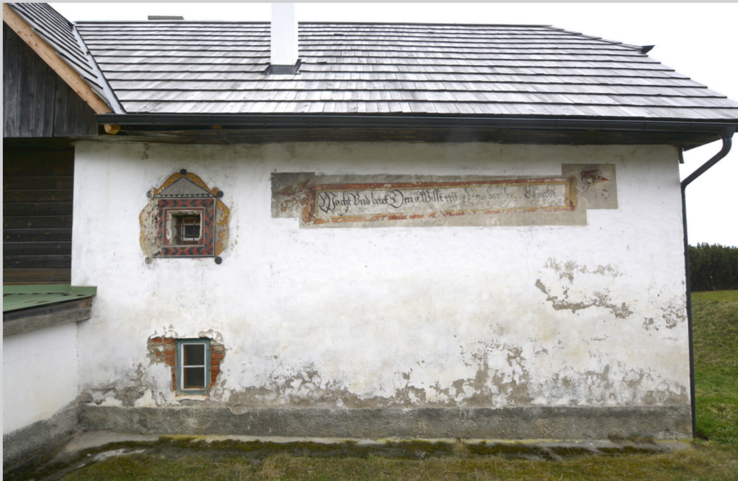
Zustand vor der Restaurierung 2017, Nordfassade
