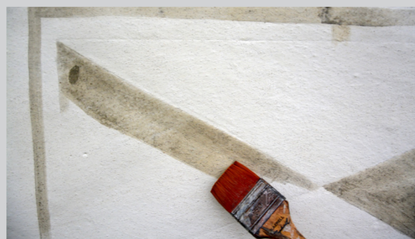
Rekonstruktion der Eckquader
