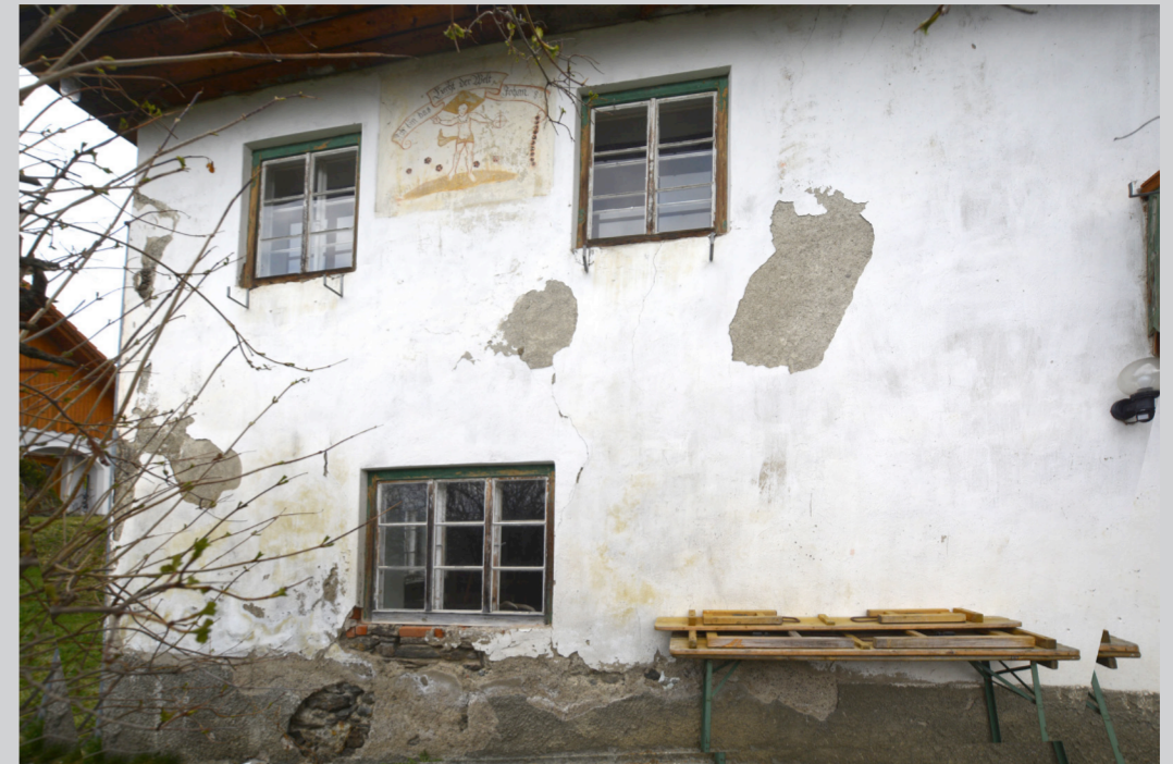
Zustand vor der Restaurierung 2017, Südfassade
