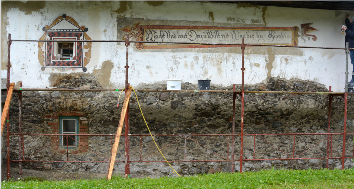
Nordfassade Steinmauerwerk, im Bereich des Fenster im EG: Ziegelausmauerung
